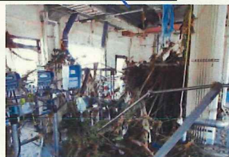
農業集落排水 下矢作地区(陸前高田市)の汚水処理施設破損
