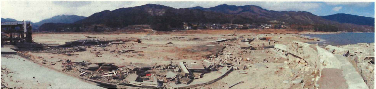
津波で全壊した高さ7.15mの農地海岸保全施設(吉浜海岸:大船渡市)【農地はガレキ堆積や表土流失など甚大な被害】
