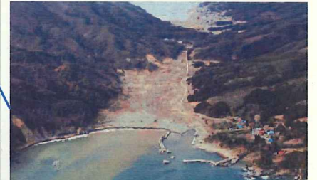
農地海岸保全施設 小谷鳥地区(山田町)堤防L=362m全壊
