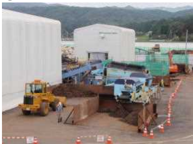
①二次仮置場・処理プラント
