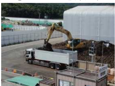
⑦ダンプへの積み込み
