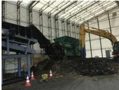
②廃棄物の破碎機
