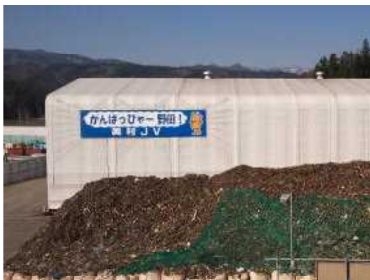
野田村米田地区災害廃棄物処理プラント（2013年4月撮影）
