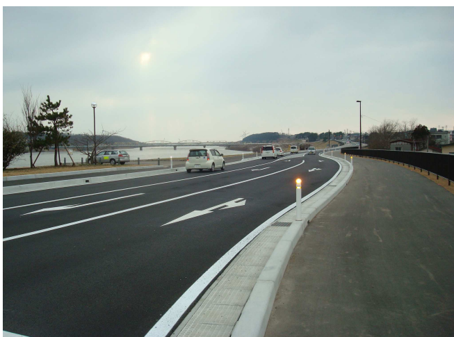
秋田市道 割山南浜線 (平成25年3月27日供用)
