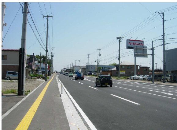
国道101号 能代市寿域長根 能代拡幅 平成24年5月31日供用
