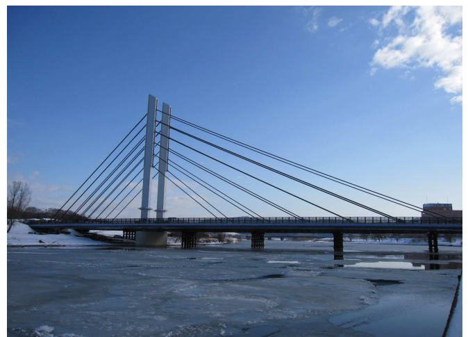
由利本荘市道 由利橋通線 由利橋
