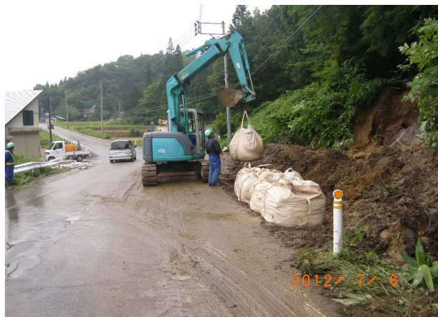
県単道路維持修繕事業((主)横手東成瀬線 応急処理工)
