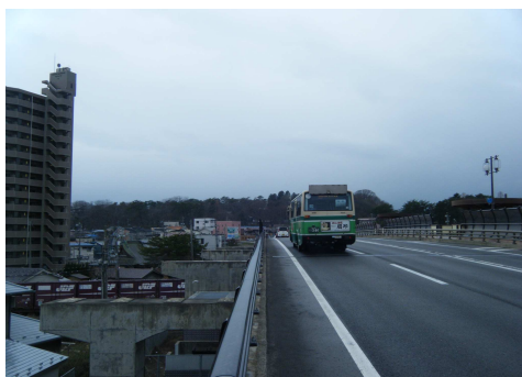
【橋梁の総合的な拡幅・補強により防災性能向上】
