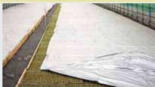
緑化始期：べた張り除去の様子
