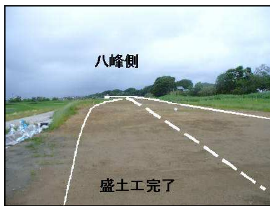
○道路改良[国道101号須田バイパス] (舗装工着手前状況 H25供用予定)
