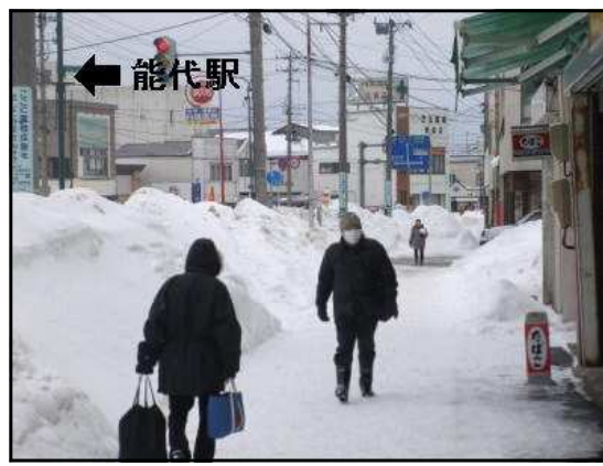
○防雪対策[(一)富根能代線畠町工区] (歩道消融雪設備 着手前状況)
