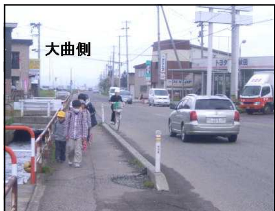
○歩道拡幅[(主)大曲横手線静町工区] (着手前全景)
