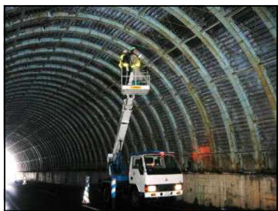
○道路附属施設の点検 [スノーシェルター点検イメージ]
