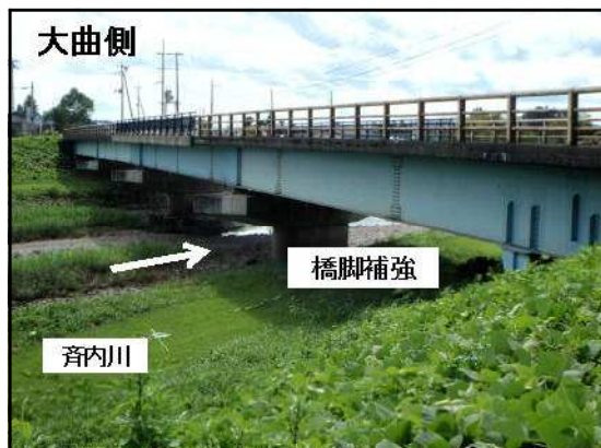
○橋梁補修[国道105号上長野橋工区] (着手前全景)
