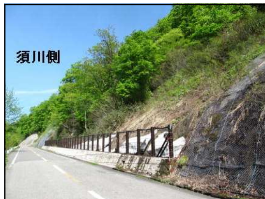
○法面对策[(一)仁郷大湯線仁郷山国有林工区] (着手前全景)
