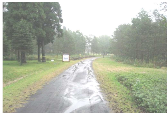
○園路(ジョギングコース)舗装改築 [北欧の杜公園]
