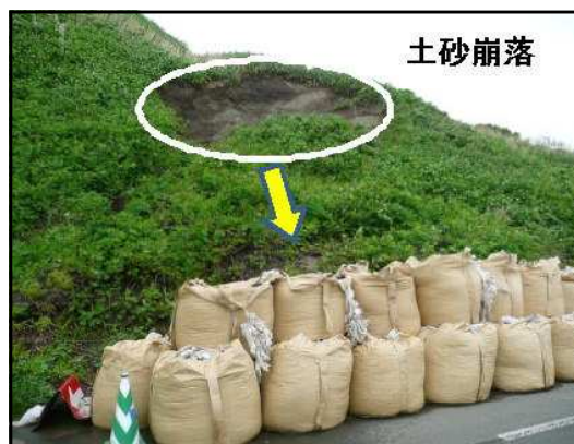
○法面对策[(主)男鹿半島線芦の倉工区] (H25～ 着手前全景)
