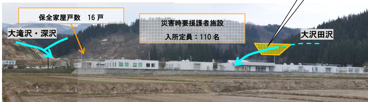
○災害時要援護者対策[火山砂防事業 寺田川（湯沢市）]
