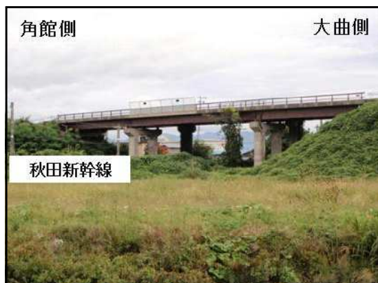
○橋梁補修[国道105号長野跨線橋工区] (H25～ 着手前全景)
