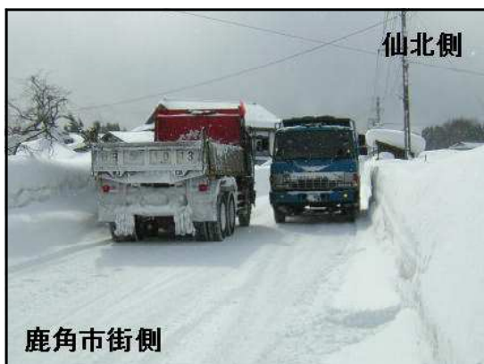
○堆雪帯拡幅[国道341号熊沢工区] (H23～ 着手前状況)
