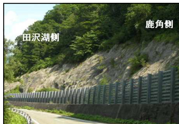
○雪崩予防柵[国道341号玉川工区] (H25 着手前全景)
