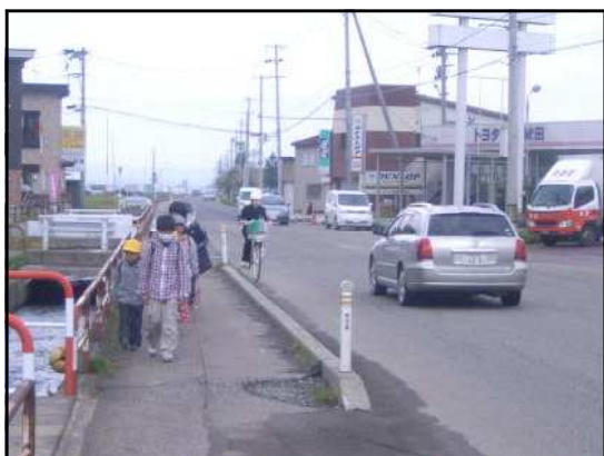
○歩道整備[(主)大曲横手線静町工区] (H24～ 着手前状況)
