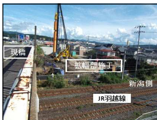
○道路改良[国道107号本荘道路工区] (H11～ 事業中状況)
