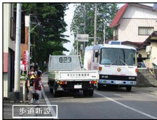
○歩道整備[(主)角館六郷線畑屋工区] (H21～ 着手前状況)
