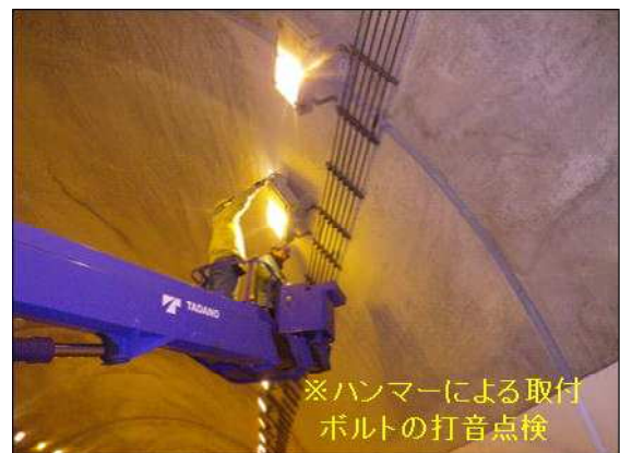
○トンネル内照明灯点検 〔二ツ井森吉線 たたらトンネル〕
