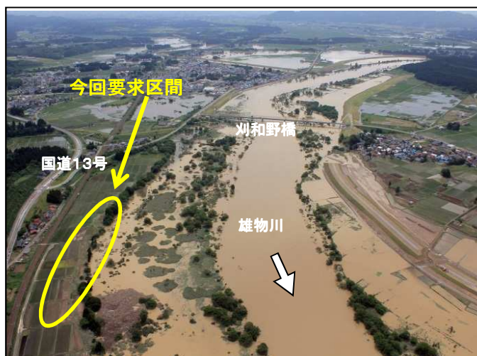
国直轄河川事業 雄物川 (大仙市) 築堤工
