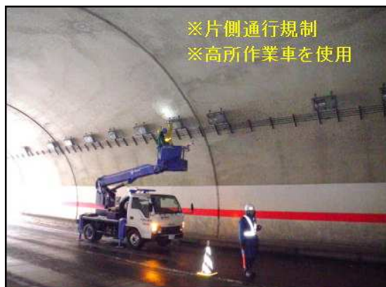
○トンネル内照明灯点検 〔(主)二ツ井森吉線 たたらトンネル〕
