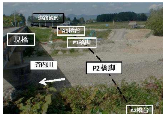
○橋梁整備[角館六郷線斉内川橋工区] (整備前全景)
