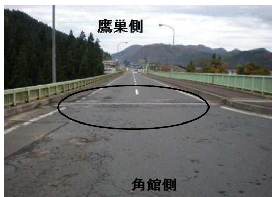
○橋梁補修[国道105号新牛滝橋工区] (全景)
