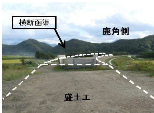
○道路改良[国道103号葛原BP] (盛土前全景)
