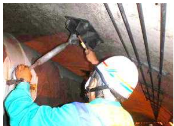
○ジェットファン取付部の点検 〔国道108号 仙秋鬼首トンネル〕
