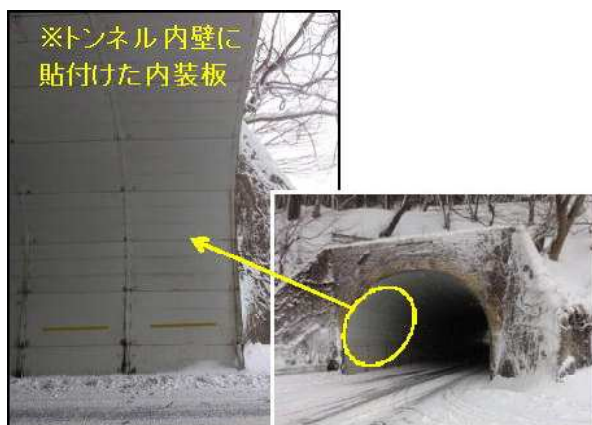
○トンネル内壁の内装板 〔(一)きみ后坂藤里峡公園線 きみ后坂トンネル〕
