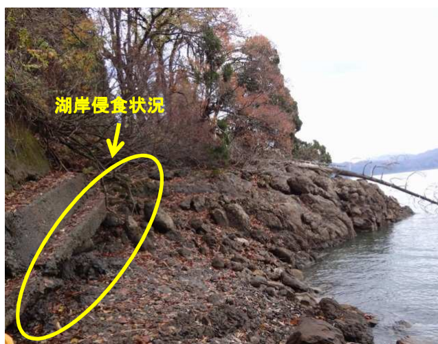
広域河川改修事業 田沢湖 (仙北市) 護岸工
