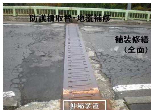
○橋梁補修[国道105号新牛滝橋工区] (橋面補修、地覆補修による長寿命化対策)
