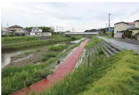
護岸の緑化に配慮した川づくり（草生津川）
