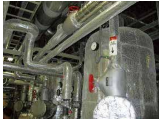
蒸気バルブの保温による省エネ改修事例
