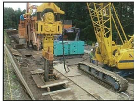
遮水壁(南側施工中)
