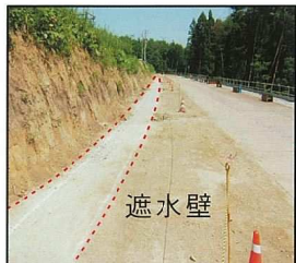
遮水壁(南側完成後)
