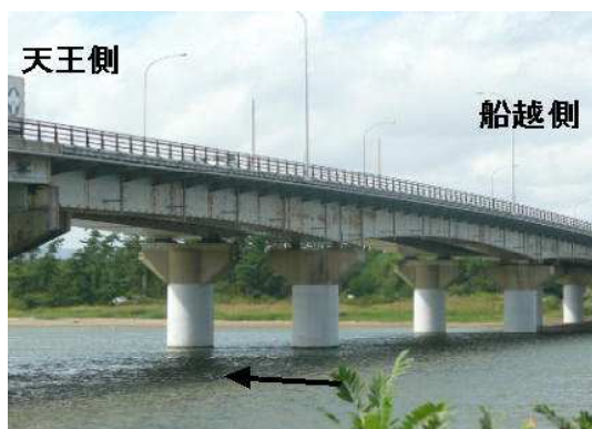
○橋梁補修[国道101号男鹿大橋工区] (全景)
