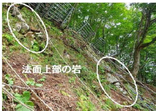
○法面对策[鳥海矢島線笹子峠工区] (法面上部の状況)
