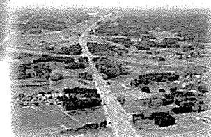
二井田真中 I C 付近の状況
