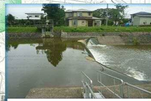
岩瀬頭首工 (馬踏川上流)
