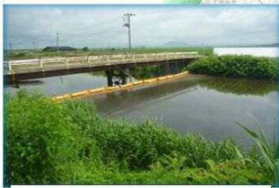
シルトフェンス (写真は馬踏川)
