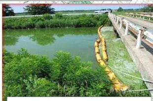
馬踏川 H24.7.21 レベル6(フェンス下流側)
