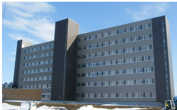
大曲駅前第二地区 都市再生住宅
