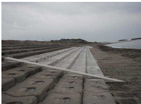
工事完成(H23)
