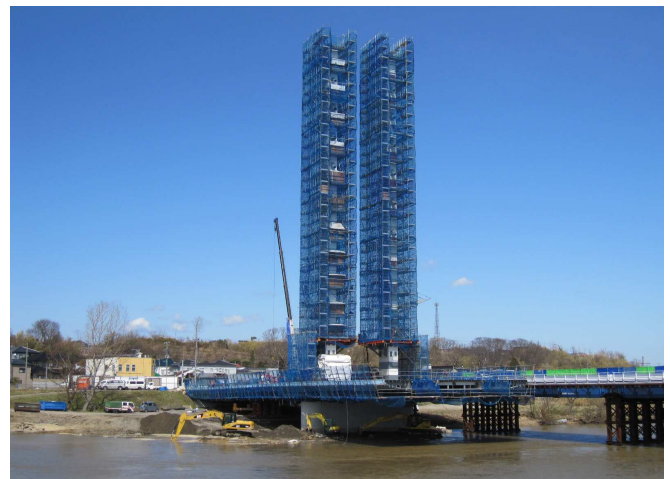
由利本荘市道 由利橋通線 由利橋上部工架設状況
