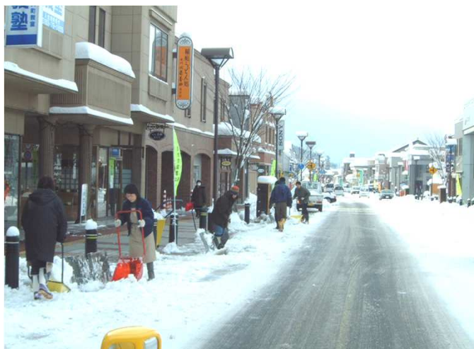
流雪溝による住民参加の除雪作業（湯沢市）
