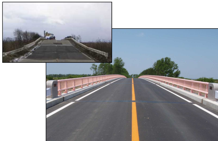
地方特定道路整備事業(道村大川線 大潟村御幸橋)
