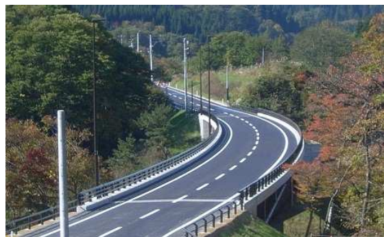
主要地方道 湯沢栗駒公園線 湯沢市 黒滝橋工区 平成23年11月2日開通
