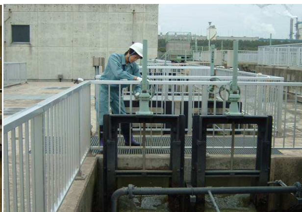
処理施設の点検
