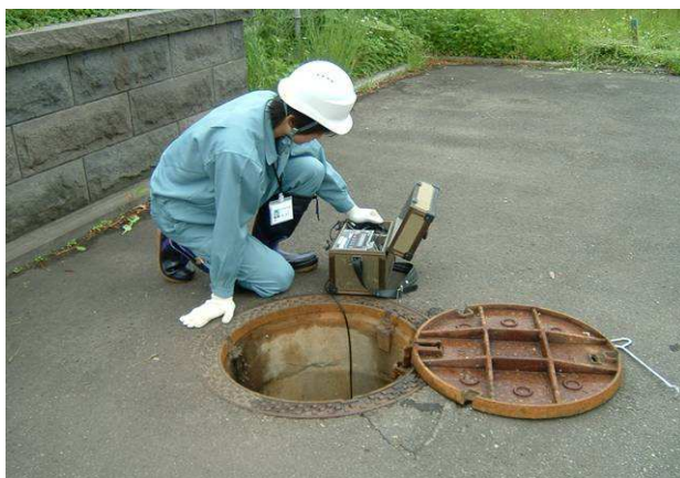
マンホールの点検
