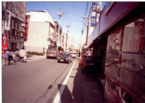
【歩道もなく危険な道路】
