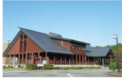
①管理棟 (木造2階建 773.58㎡)
