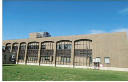
②研究棟 (鉄筋コンクリート2階建 2,104.16㎡)
