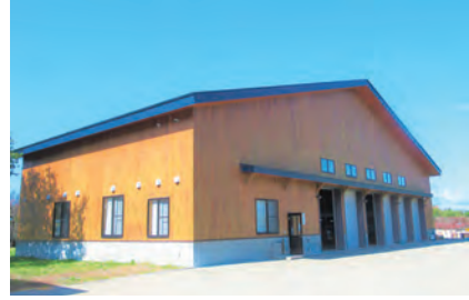
⑦機械実習棟 (木造平屋建 450.00㎡)
