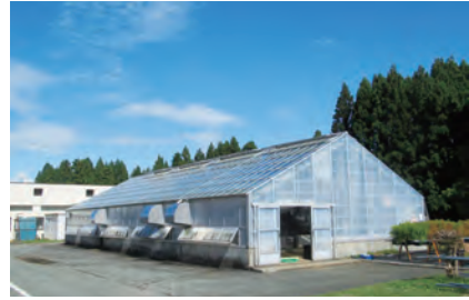
③ガラス温室 (鉄骨平屋建 230.00㎡)
