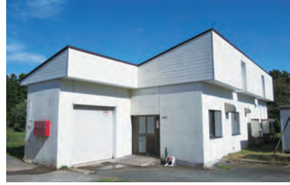
④きのこ栽培実験棟 (鉄骨平屋建 98.60㎡)
