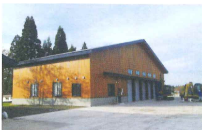
⑦機械実習棟 (木造平屋建 450.00㎡)
