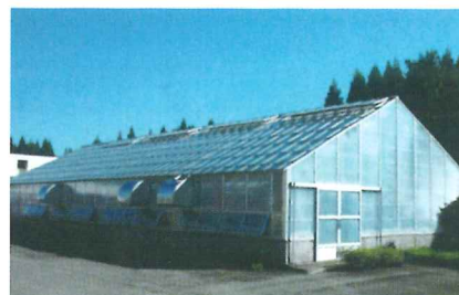
③ガラス温室 (鉄骨平屋建 230.00㎡)
