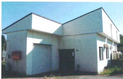
④きのこ栽培実験棟 (鉄骨平屋建 98.60㎡)
