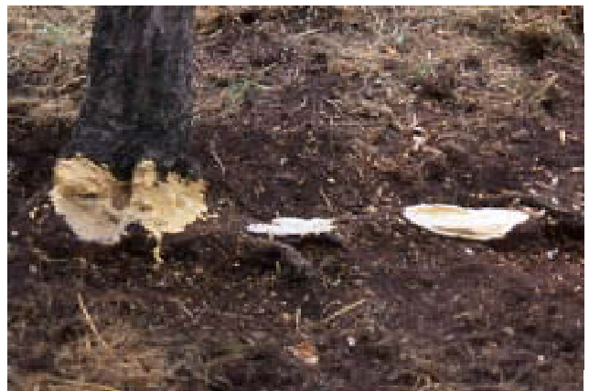
写真6 根の損傷部から主幹部へ腐敗する
