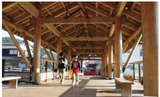
公共施設への杉材の活用も積極的に行われており、平成16年に完成した屋根付木橋の「きごころ橋（橋長60m）」。
