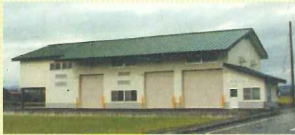
▲「乾燥調製貯蔵施設」
