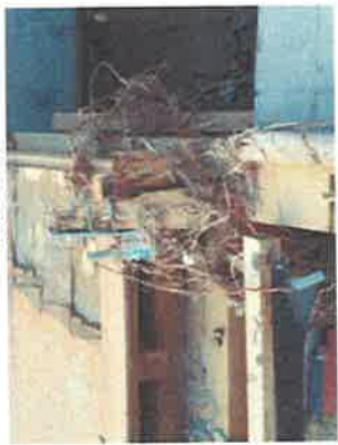
土台の割裂・折損
