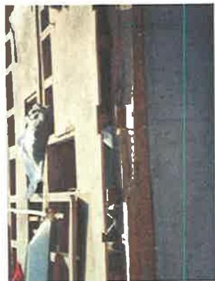
土台の割裂・折損
