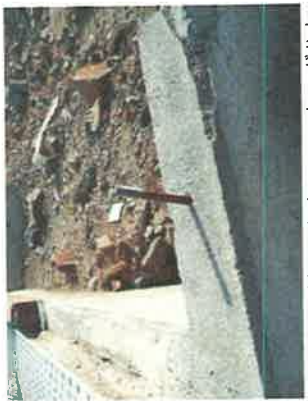
ナットが見られないアンカーボルト
