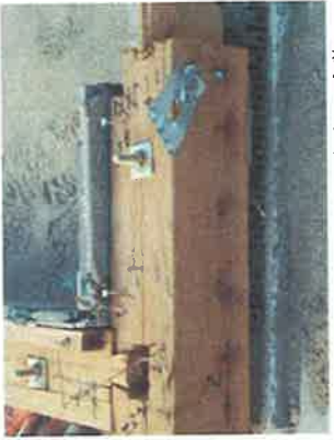
ナットが見られないアンカーボルト
