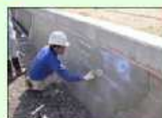
水路の補修・更新
