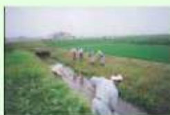
水路の泥上げ
