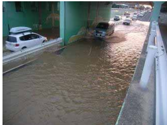
危険！冠水時の車両進入
