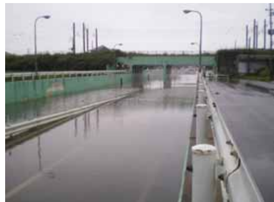
アンダーパスの冠水事例
