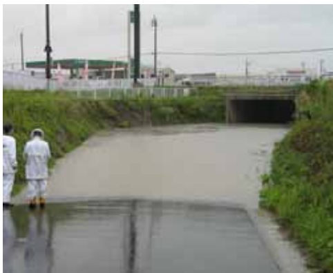
アンダーパスの冠水事例
