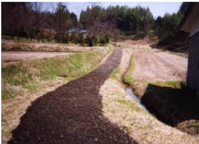
雨水により洗掘された農道の補修
