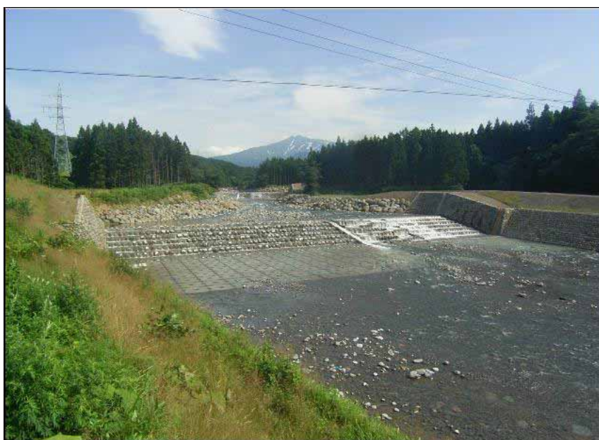
〈鳥海山噴火の影響区域にある白雪川で、現地発生材の玉石張りや魚道の設置など環境に配慮した砂防床固工(縦断侵食の防止)〉
