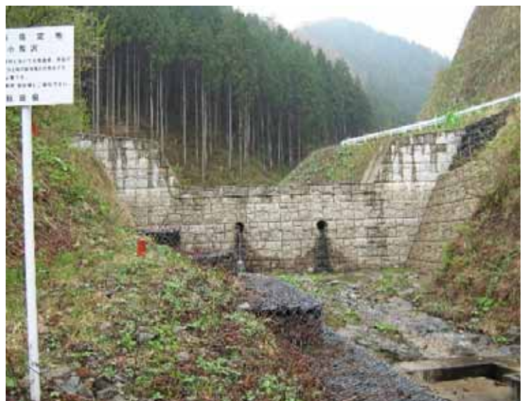
(災害時要援護者施設(老人福祉センター)を 保全する砂防えん堤大館市・小雪沢)
