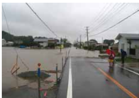
道路冠水状況(秋田市笠岡地区)
