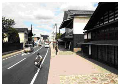
電線類の地下埋設化(羽後町)
