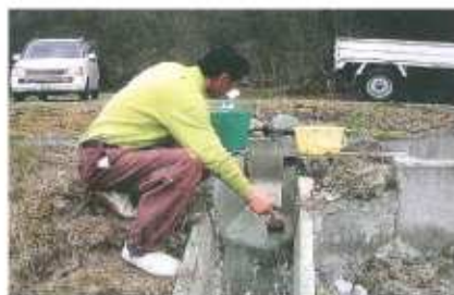
水路 目地詰め
