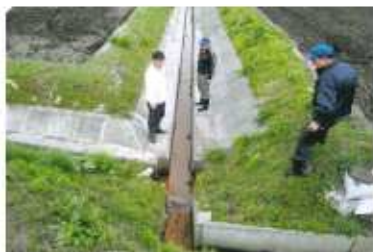
水路の機能診断
