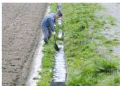
水路の泥上げ
