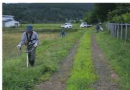
路肩・法面の草刈り
