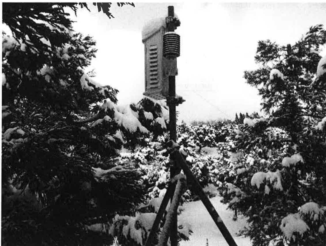
写真-2 温度データロガーの設置状況
