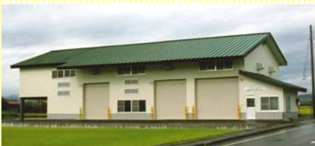
▲「乾燥調製貯蔵施設」
