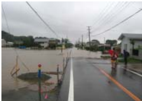
道路冠水状況（秋田市笠岡地区）
