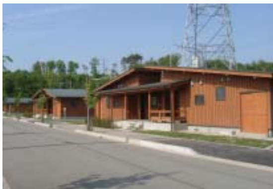
県営南ヶ丘住宅 ( 秋田市 )
