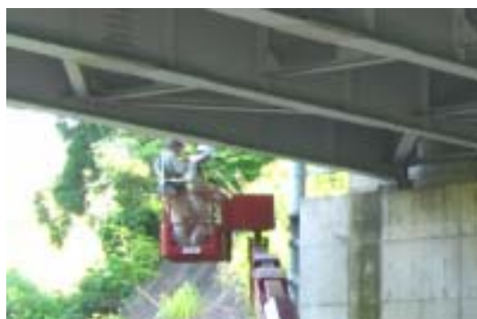
橋梁点検作業
