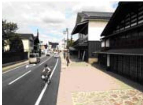
電線類の地下埋設化(羽後町)
