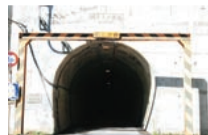
国道と集落をつなぐトンネル
