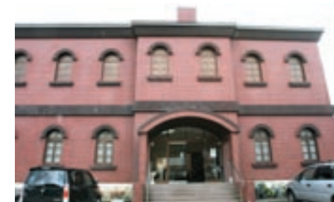
JR駅舎を兼ねる郷土史料館「湯沢市院内銀山異人館」は、ドイツ人技師住居の外観を模している
