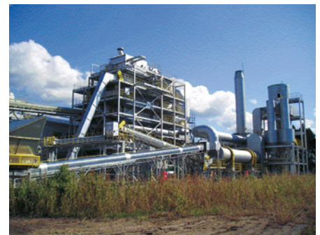
能代バイオマス発電所
