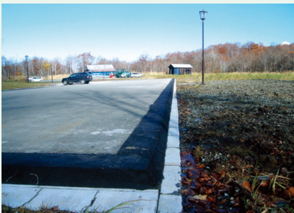
由利本荘市：フォレスト鳥海 (側溝、境界ブロック：スラグ入りコンクリート製品)
