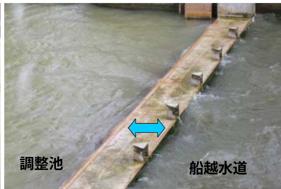
左岸放流ゲート
