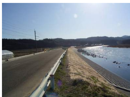
工事完成(H20)
