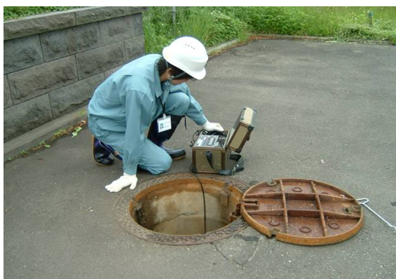
マンホールの点検
