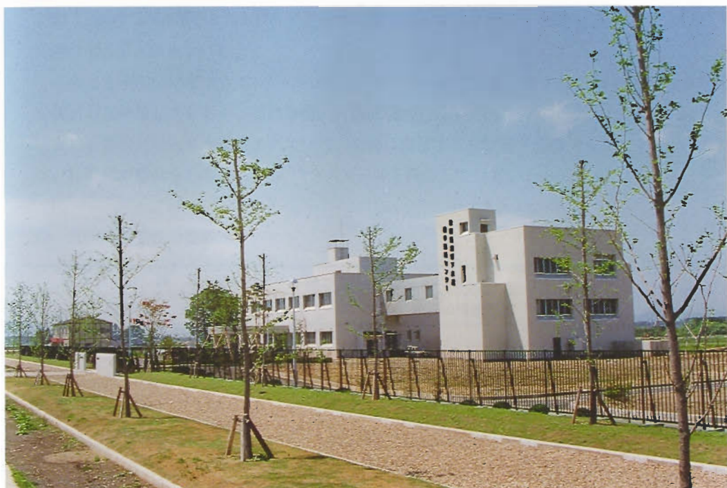
横手処理センター
