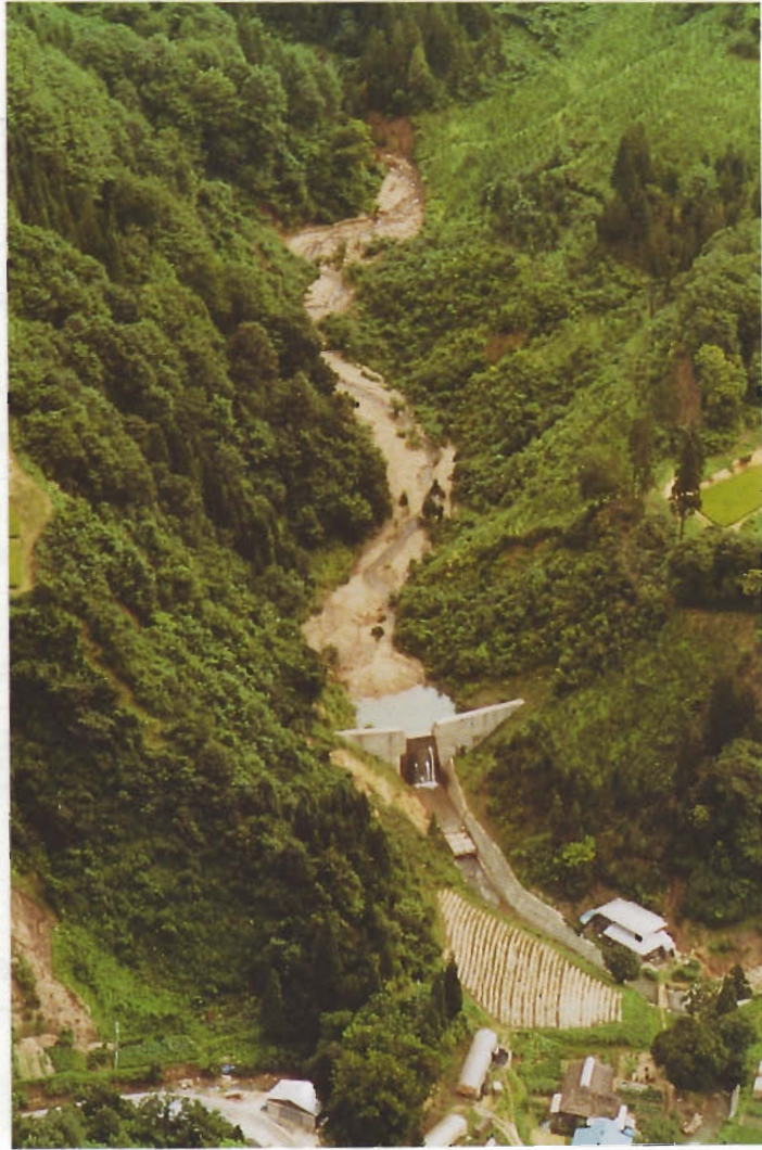
瘦長根沢川砂防ダム(雄勝郡皆瀬村) 昭和54~55年 L=53.0m H=11.5m VS 26,600㎡
