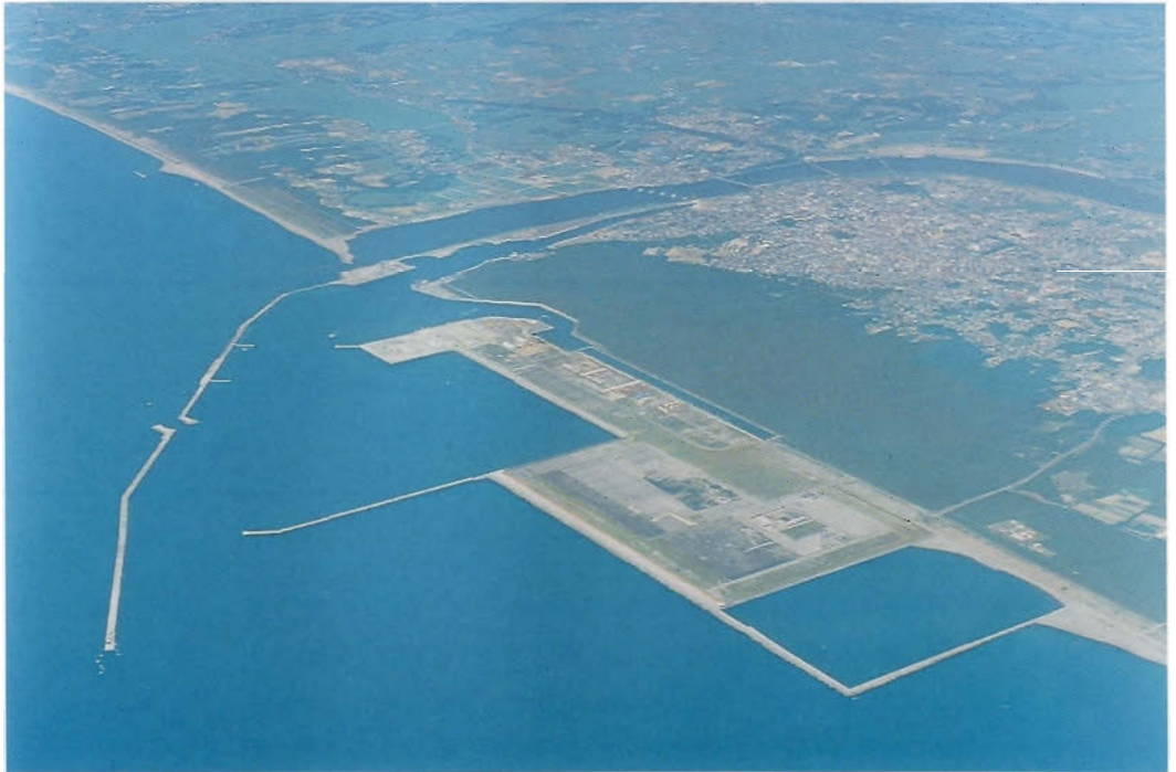
工事中の能代港石炭火力発電所用地
