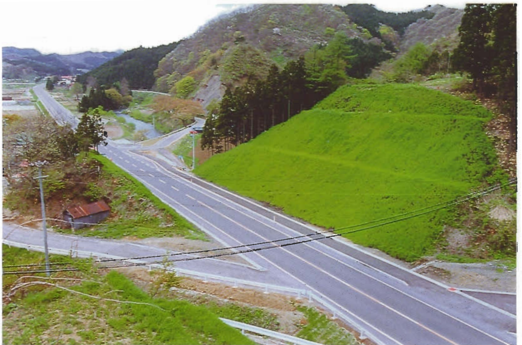
国 道 107 号 奥ヶ沢バイパス (東由利町宿)
