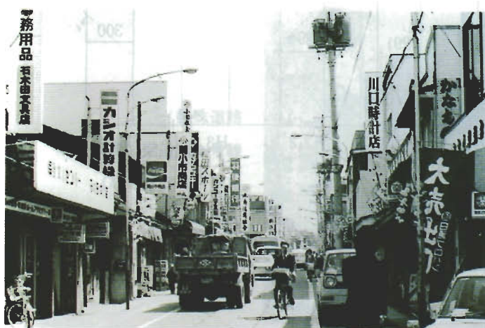
花輪通線（鹿角市）着工前
