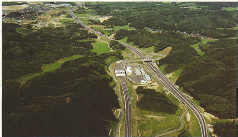
(平成 3 年 7 月開通、東北横断自動車道釜石秋田線秋田南 I C 付近)
