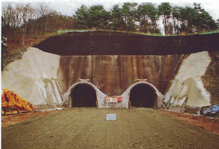
サイロット完成状況
