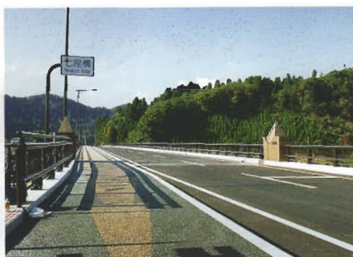
全 景 (左岸より)
