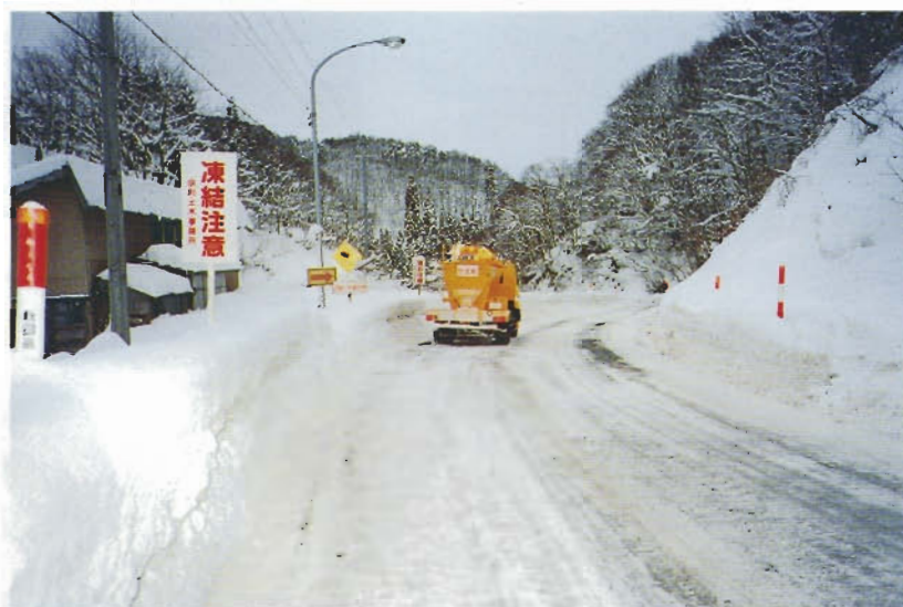
消雪剤散布状況
