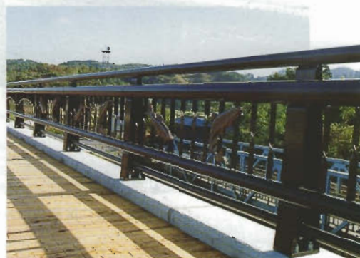
サケの模様を入れた高欄と木レンガ舗装……橋梁部
