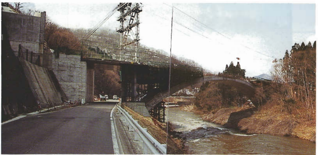
アーチ部が完成し、上床版及び鉛直材の施工にとりかかっている。(H 6. 5 月)
