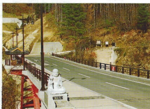
全 景 (左岸より)
