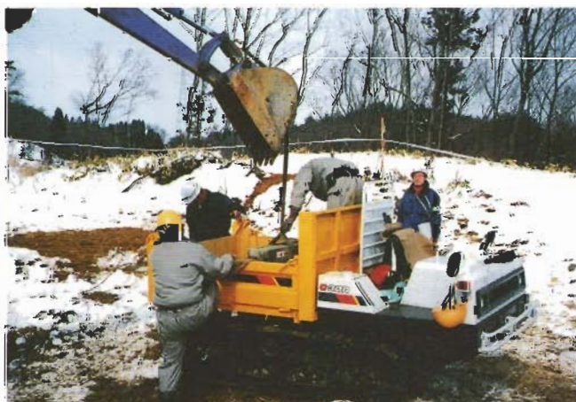
移送の作業状況
