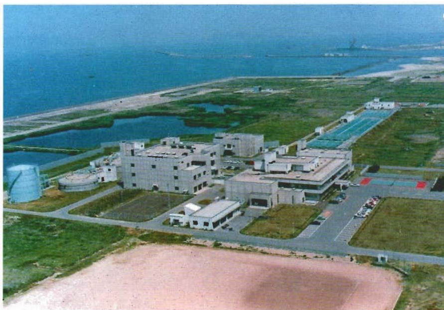
秋田湾・雄物川流域下水道 臨海処理センター
